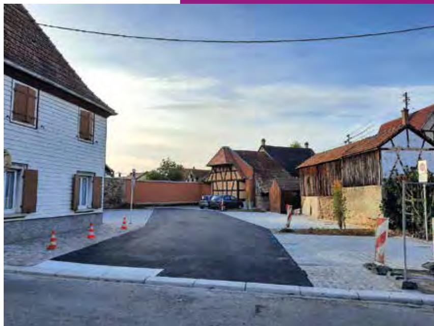
*Les travaux d'aménagement ont permis de créer 16 places de stationnement dont une pour personne à mobilité réduite (place PMR). Ils ont nécessité la réfection du Rempart, le crépissage du mur en briques et l'habillage du pignon existant, par la mise en place de la façade à colombage.*
